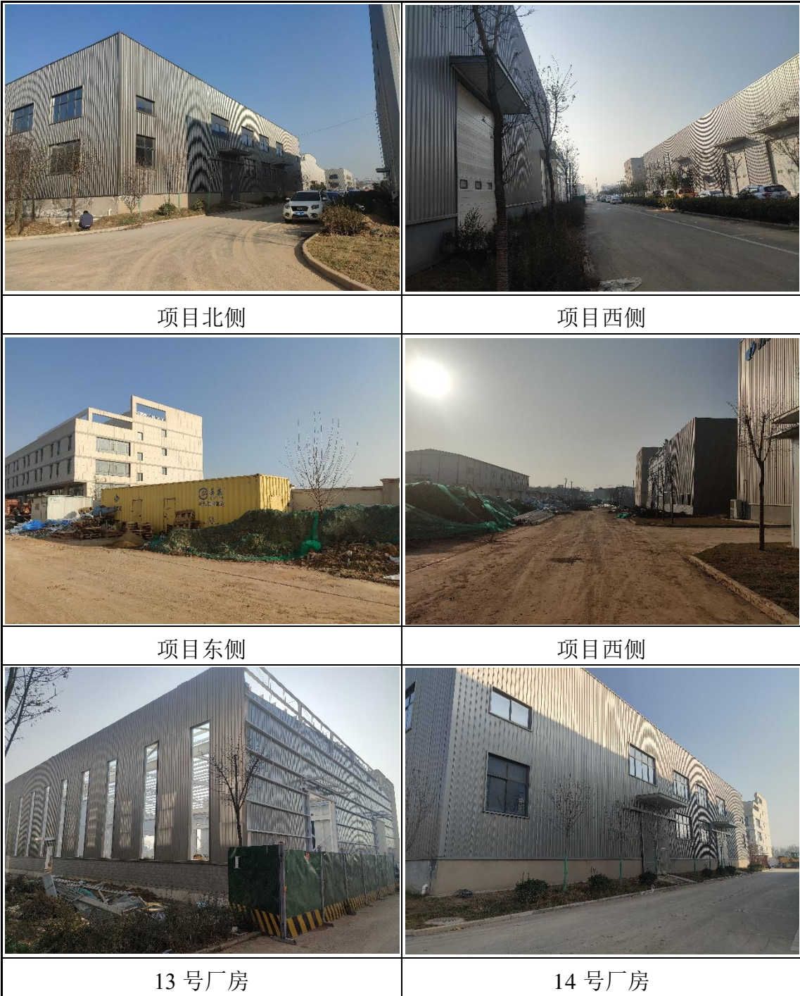
附图 5 项目现场照片
